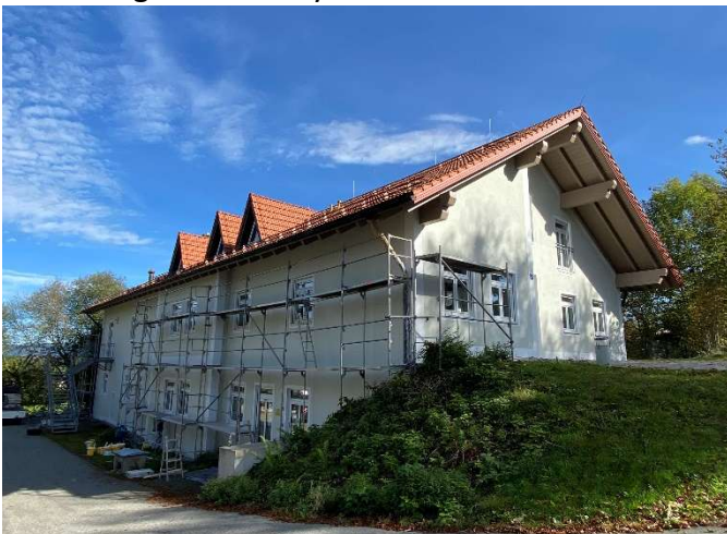
Renovierungsarbeiten am Don-Bosco-Haus
